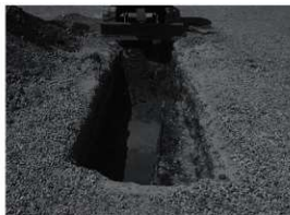
トレンチ全景（北から）
