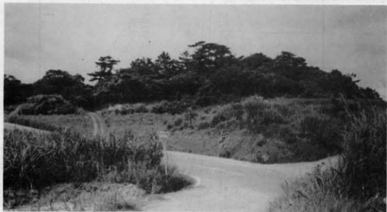
写真3-15 屋我グシク遺跡群全景(南西側より)
