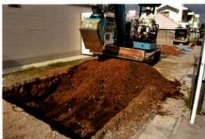
1. 表土掘削作業
