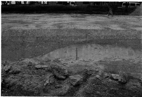
写真2 Lライン断面状況
