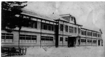
写真 13 大正9年完成の校舎
