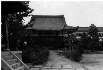
写真9 戦災から復興した正寿寺 阪神・淡路大震災で再び全壊した
