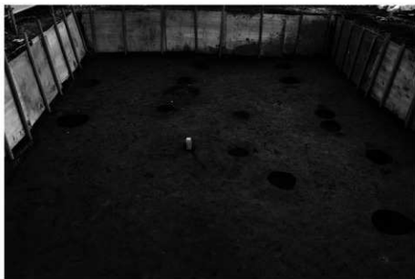
第 1857-6 図 北側完掘全景（南）
