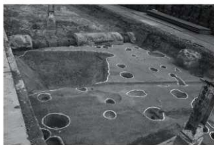
4. 掘立柱建物4 検出状況 (南西から)
