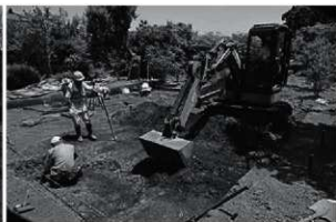
2区の表土掘削
