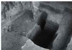
(4) 柱穴 SK03 掘削状況（南東から）
