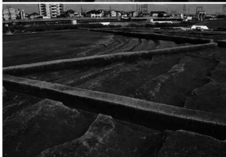
溝群 (南部) (南東から)
