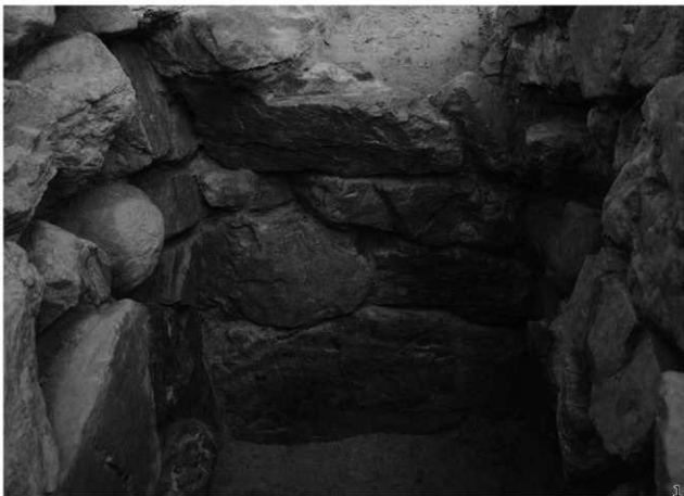
1. 3号墳 石室奥壁 (南から)
