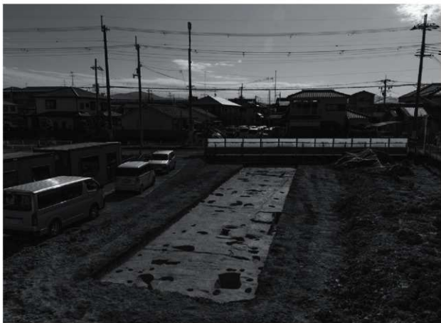
図 14 調査区全景（北西から）
