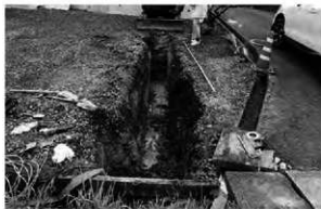
下水管工事（北から）
