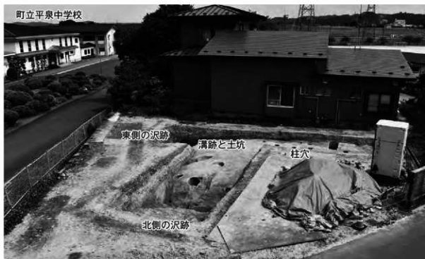
写真図版4 国衛館跡第16次調査区全体(北から)
