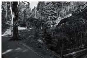
堂付近の白山沢上流（南から）
