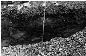
下水管工事断面（西から）
