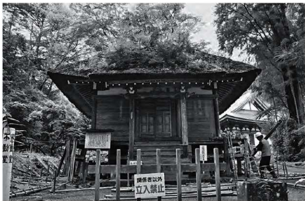
姫待不動堂 解体前現状（南から）
