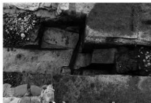
岸側の状態（西から）
