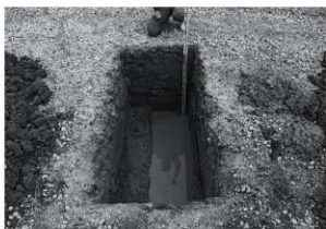
図36 調査区全景 西から
