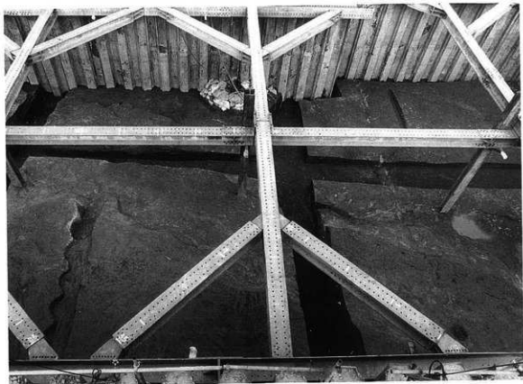
晩期自然河川NR1001 A5・A6トレンチ（南から）
