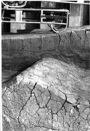
Aトレンチ 畦畔断面Fライン（西から）
