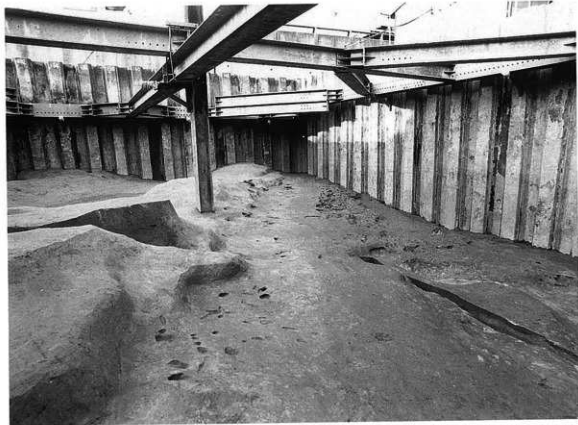
晩期自然河川NR1001 A5・A6トレンチ（東から）
