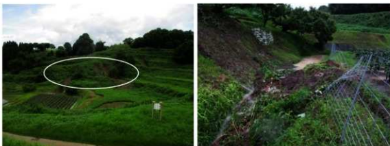
南部斜面地区 (B 地点) 左被災後遠景より、右崩落斜面と右側、柵を挟み営農地
