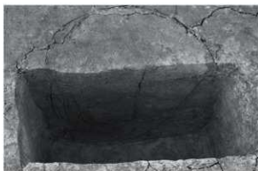
写真 23 SA1 P3 断面 (南東から)
