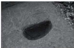
写真 41 SP7 断面 (北東から)
