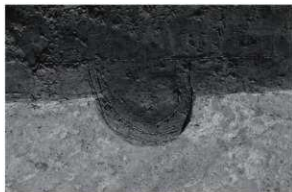
写真 36 SP3 断面 (南から)
