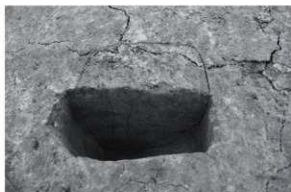
写真 47 SP13 断面 (南から)
