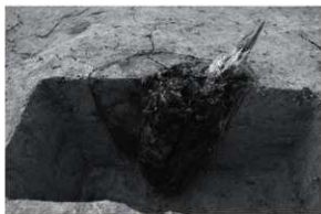
写真 12 SB2 P3 断面及び柱根状況 (南東から)
