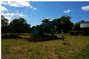
2. 重機による表土除去（北西から） [Z9460]
