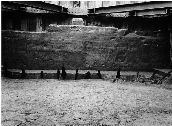
Bトレンチ 右岸堤防基礎杭列
