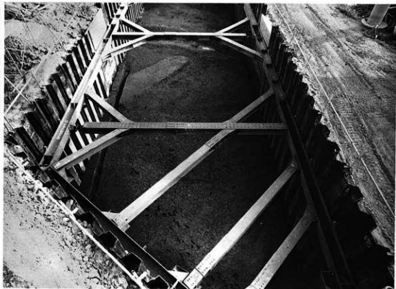
Aトレンチ SA101・SD101 (北より)
