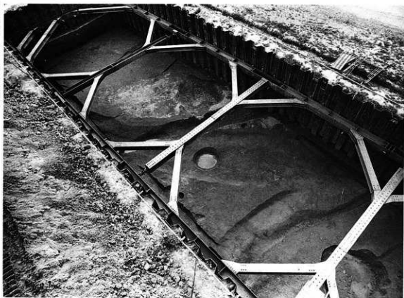
Aトレンチ 溝状落ち込み (東より)
