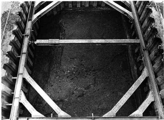
8Aトレンチ SD213 (南より)
