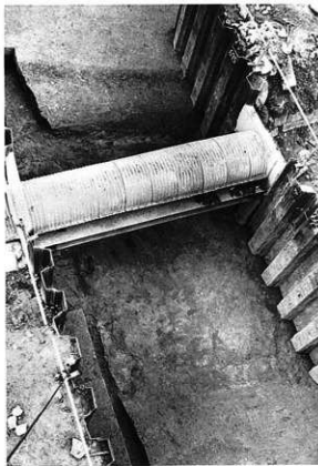
Aトレンチ SD445 (北より)
