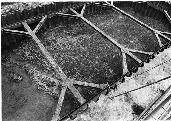
SR6501・6502 (1Bトレンチ、南西から)
