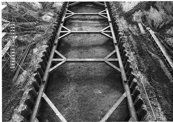
SR6104~6106 (2Aトレンチ、東から)
