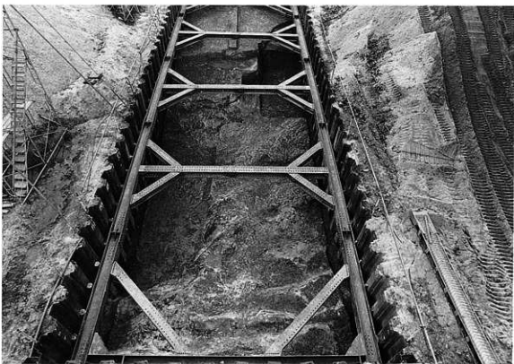
SR6201 (5Aトレンチ、東から)
