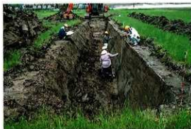
4 確認調査第16トレンチ 作業風景
