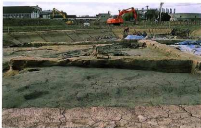
1 水田2東西ベルト (B区内 北から)
