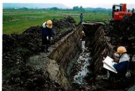
3 確認調査第21トレンチ 作業風景
