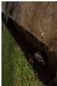
西壁セクション (南側から)
