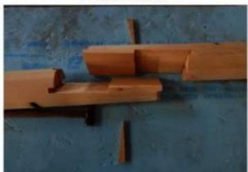
柱根継ぎ模型（金輪継ぎ）
