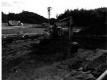
写真1 重機による表土掘削状況
