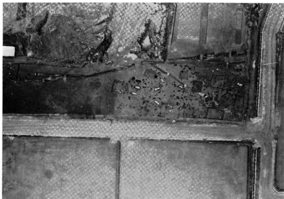
a. 井原遺跡群上学地点全景（上から）
