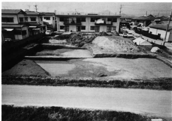
a. 調査地点全景 (南から)
