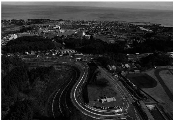
令和3年度調査区遠景・W→
