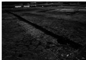
南北トレンチ断面（北東から）
