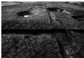
南北トレンチ断面（南東から）
