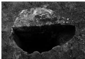
SBA5・PPA66 断面 (南西から)
