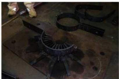
写4.5.19 柱頭/バンド取替鋼材曲げ加工
