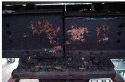
写4.6.6 橋脚上の橋桁およびベースプレート腐食状況
