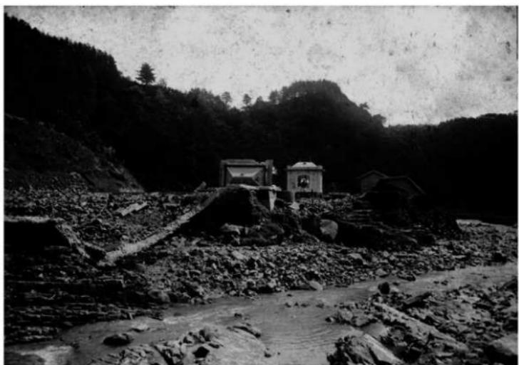
古写4 水害被災状況① 濾過池の被災を上流側より見る。制水井1号上屋が転倒している。
