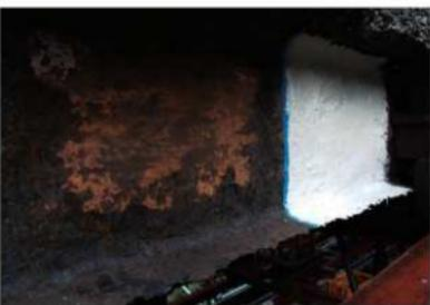
写真4.5.1 鉄部塗装 橋桁(再用)ケレン、下塗
