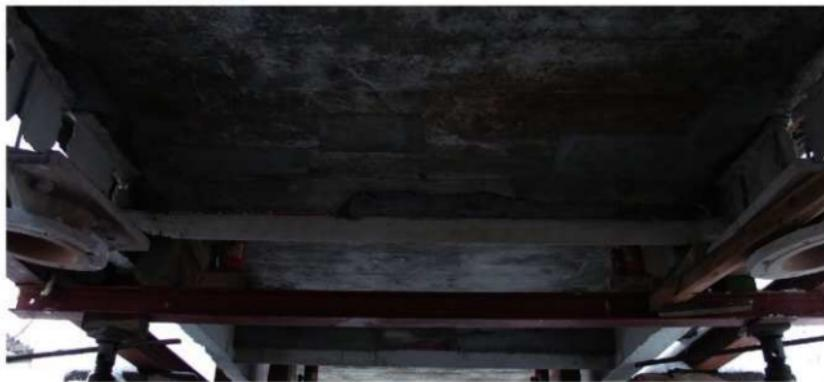
写4.5.10 仮置き状態での床版断面修復、橋桁防護処理施工状況
