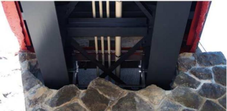
写4.5.14 同上、石積みと補強鉄骨の納まり、防鳥ネット取付 配管は別途工事での取付
