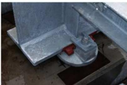
写4.5.18 新設可動支承(アンカーベルトクラウト施工前)
