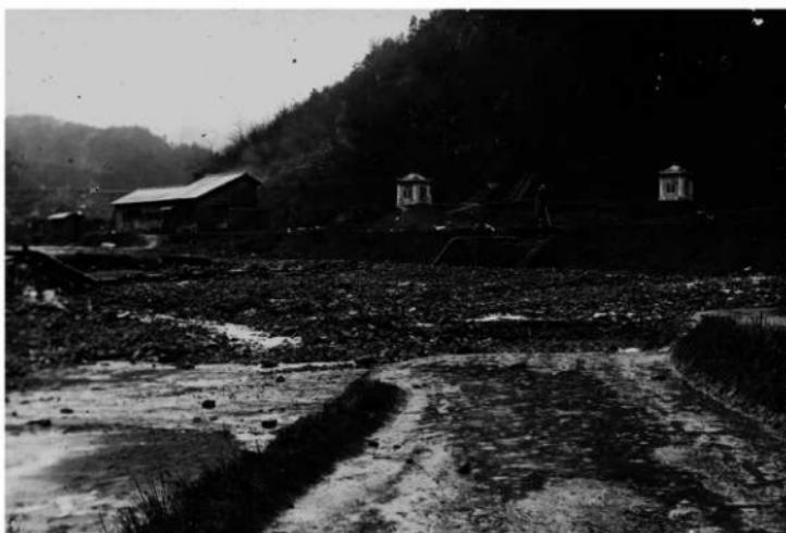
古写5 水害被災状況② 同上、下流側より見る。下流側管理橋及び門柱が破損している。
