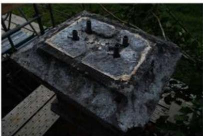
写4.7.1 剥離状況 写真はパイプを仮に入れている状況
