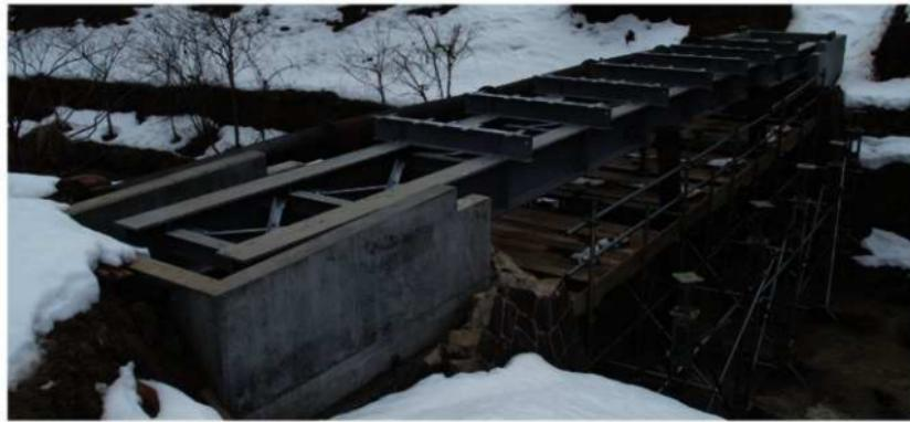
写4.5.11 新設基礎打設、補強鉄骨据付状況
