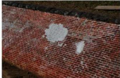
写4.8.2 煉瓦地補修及び欠損部のモルタル補修 破損状況は写3.219
