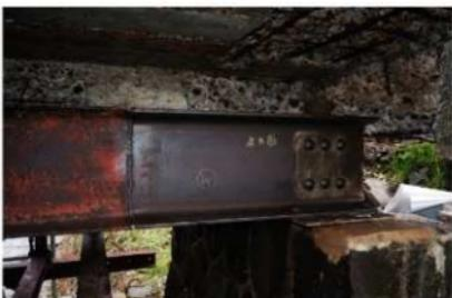
写4.6.5 支承上の橋桁端部補修状況（矧鉄） 破損状況は写3.2.15
