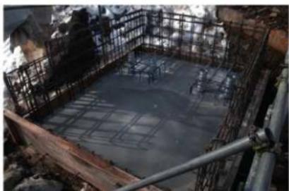
写4.5.17 新設基礎配筋・コンクリート打設
