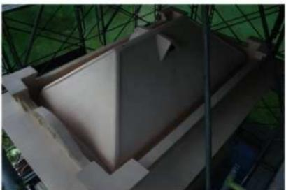
写4.2.21 工程14-2 屋根面の仕上げ 塗膜防水
