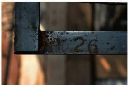
写4.2.11 工程9 鋼材補修 部分溶け込み溶接
