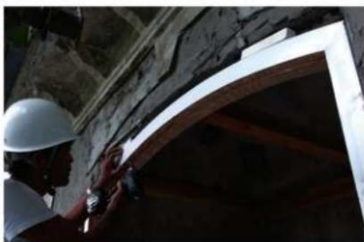
写4.3.2 建具枠の取付(同前) 木煉瓦にビス止めして固定した。
