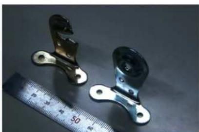
写4.3.6 ロールスクリーンプラケット補足、取付時に塗装(同前)
