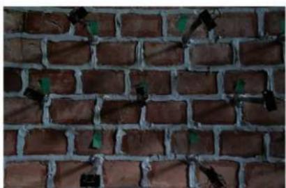
写4.2.48 接合井上屋煉瓦目地充填処理
