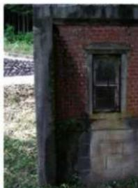
写真3.2.12 左:外壁の汚損 右:水平クラック(量水器室)
