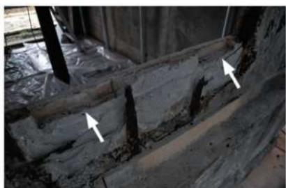
写3.3.1.5 窓枠固定木煉瓦の痕跡 (制水井3号上屋)
