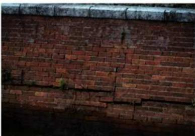
写3.1.2 5号滤過池東側壁煉瓦のクラック・段差
