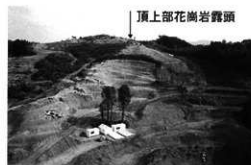
a. B-20 地点遠景 (西から)
