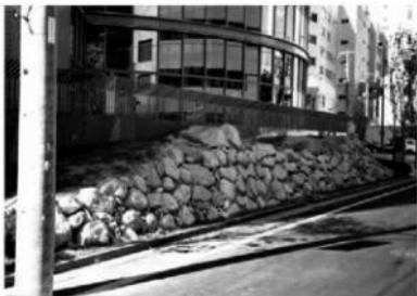
写真17 移築復元された三ノ丸石垣 完成時撮影
