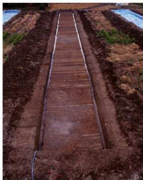
第6 トレンチ検出状況（北から）
