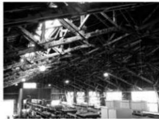
写真 39 東部分の補強鋼板
