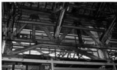
写真19 倉庫4号 木製鉛直材付ワーレントラス
