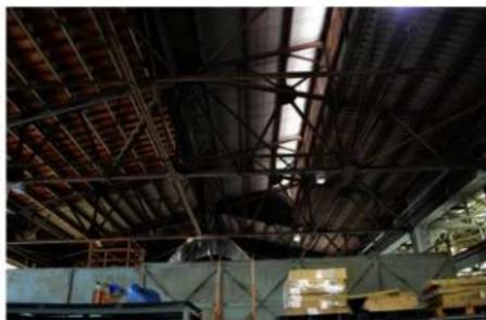
図版 23 倉庫 7号内部及び鉛直材付ワーレントラス① (東から)
