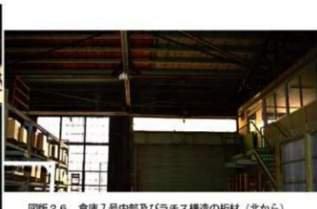
図版 26 倉庫 7号内部及びラチス構造の桁材 (北から)
