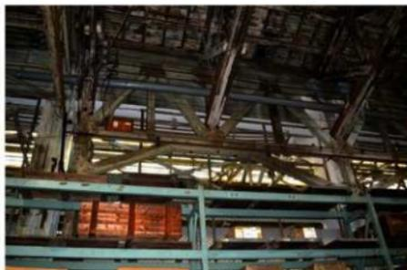
図版 21 倉庫 4号内部及び木製鉛直材付ワーレントラス (南から)
