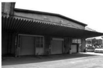
写真 7 鉄骨吊り下げ式の庇屋根
