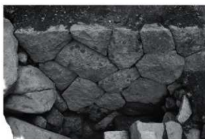
5 第3調査区 Tr-4石垣接合部 (西から)
