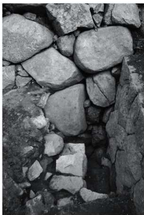
4 第3調査区 Tr-4全景 (南西から)
