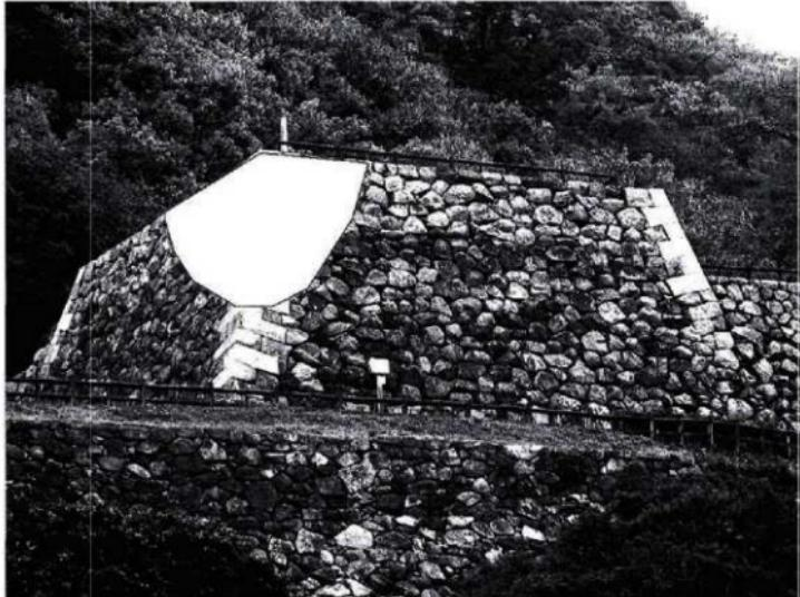
図3 石黒火事における三階櫓石垣崩落場所推定図（白抜き部分）
