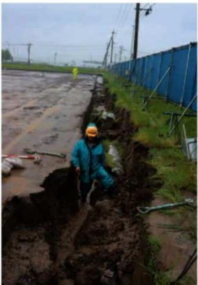
2018 年 5 月 2 日の大雨による調査区壁面崩落
