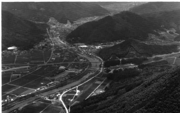
第6図 竣工後の梅田東古墳群（北から）
