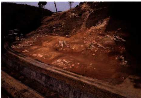
古墳群 全景 (南西から)
