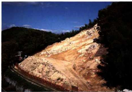
古墳群 全景 (南西から)
