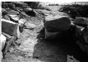
石室 右側石 (北から)
