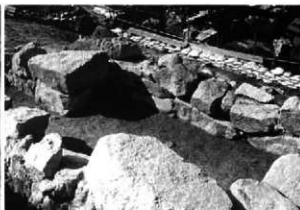
石室 右側壁 (北東から)
