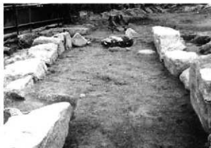
石室 玄関～奥壁 (南から)
