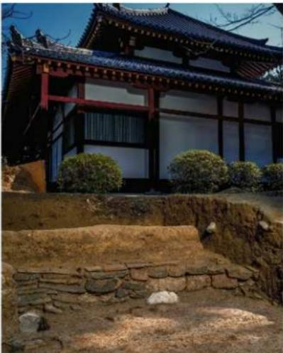
図3 四王堂の基壇西縁の瓦積み基壇
