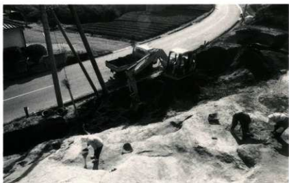
重機稼働風景
