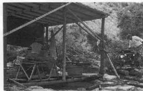
鉄滓等の水洗作業状況
