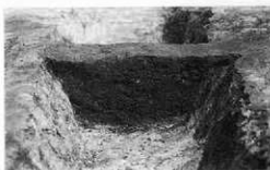
11号溝跡断面C-C' (北西から)
