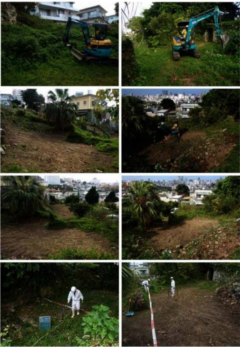
図版 36 バックホーによる伐採作業と磁気探査作業
