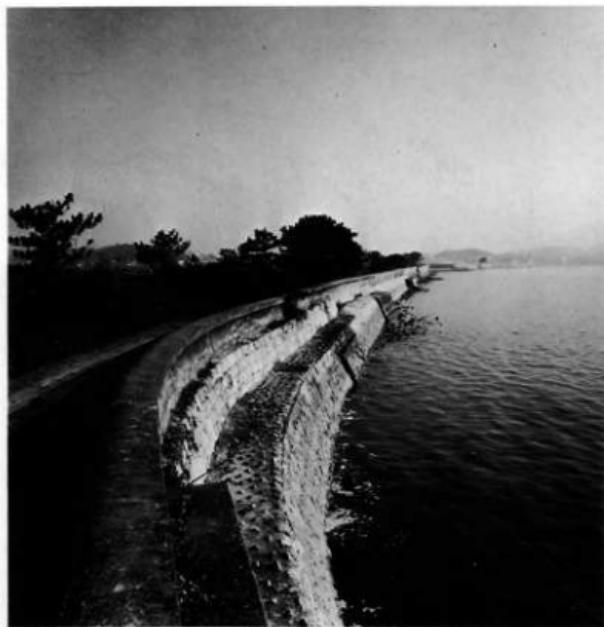
写真13. 護岸工事がなされている築堤
