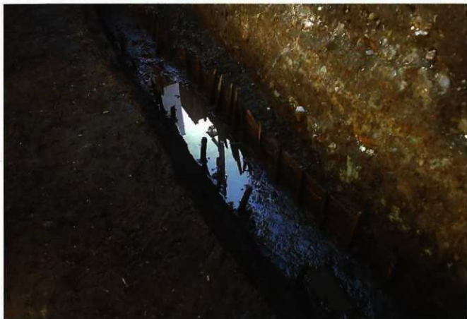
写真7 道路の側溝 (Photo 7) Gutter
