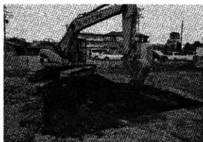
重機掘削（南より）
